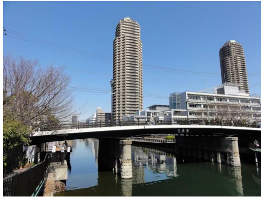
横十間川大島橋
