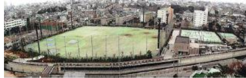
上高田調節池 写真
