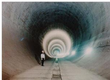
神田川・環状七号線地下調節池
