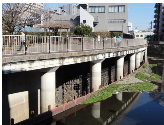
神田川取水施設 方南橋取水口
