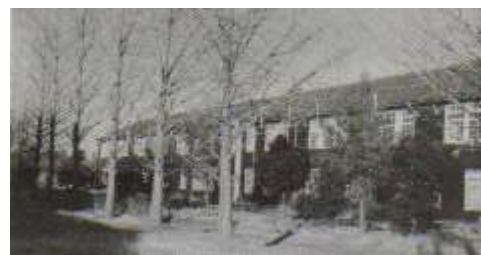
建設研修所当時の校舎(建設大学校蔵)
