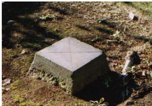
工部省三角点に類似のもの (見取り図に「大三角点？」とあるもの)
