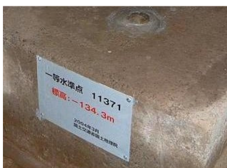
青函トンネル内の水準点
